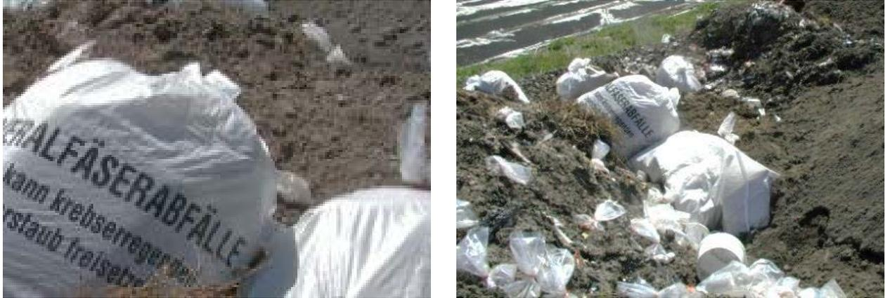
Abb. 7: Auch kleinere Mengen KMF-haltiger Abfälle müssen sofort in reißfeste und staubdichte Bigbags verpackt werden. Anschließend werden die Bigbags auf der Deponie eingebaut und überdeckt.
